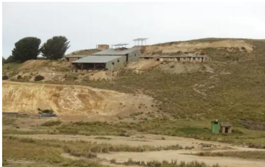
Figura 1. Vista de planta concentradora de Tiquillaca
